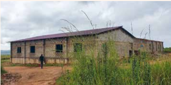
Het VTC Walani in aanbouw (foto: HMH)
